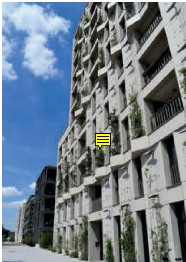
Abb. 13: Wandgebundene Fassadenbegrünung in Regalbauweise (horizontal). Quelle: BuGG
